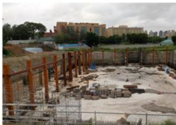
3.(4,L)-line鋼柱吊裝完成
