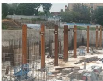
6.一節柱除鏽兼塗防鏽漆
