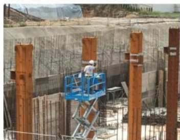
5.一節柱除鏽兼塗防鏽漆
