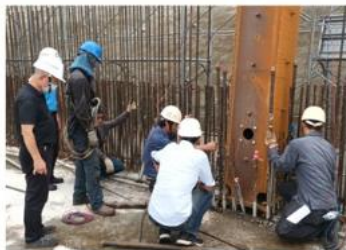
4.(L)-line鋼柱吊裝狀況排除
